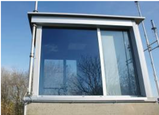
Gebäude PC, Schiessplatz Forel, 19.11.08
